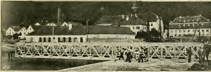
Abb. 164. Eisenbahn-Drehbrücke Bregenz. [Linie Bregenz-Lindau.]
